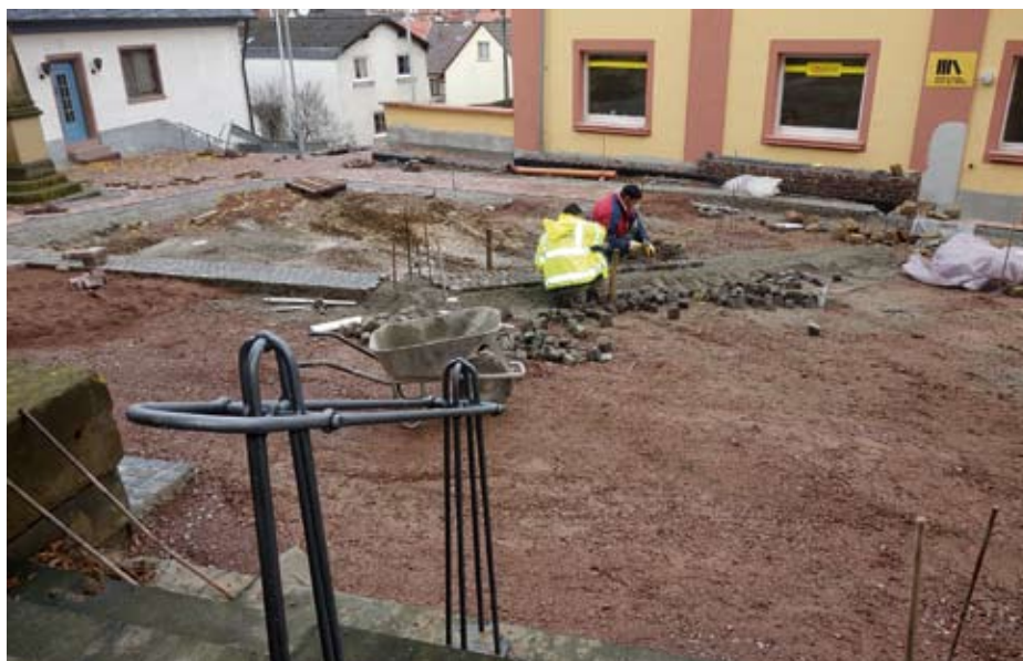
Nachdem die aufwändigen Arbeiten für den barrierefreien Zugang endlich abgeschlossen werden konnten, gehen nunmehr die Pflasterarbeiten für den Wegebau zügig voran.
