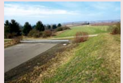
Das heute vorhandene Ausbauende, gleichzeitig Anschlussstelle für das Neubaugebiet „Leidhecke“
