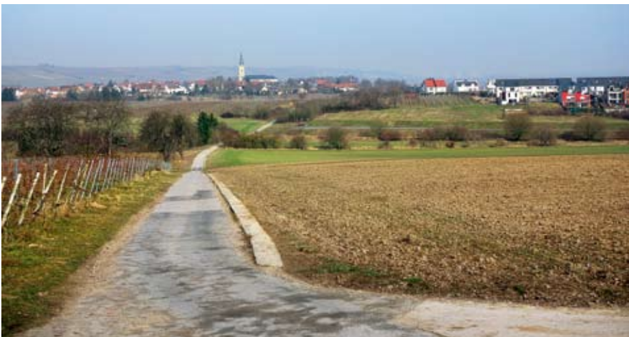
Links neben dem Baugebiet „Kapelle“ geht es weiter mit dem Baugebiet „Leidhecke“.
