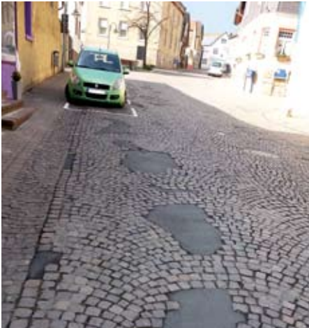
Der Flickentepich am Rathaus soll durch eine ansprechende Vollsaniierung zum Sommerende wieder im Glanz erscheinen. Auch der oft verschlammte Innenhof soll mit dem Vorplatz eine Einheit ergeben.
