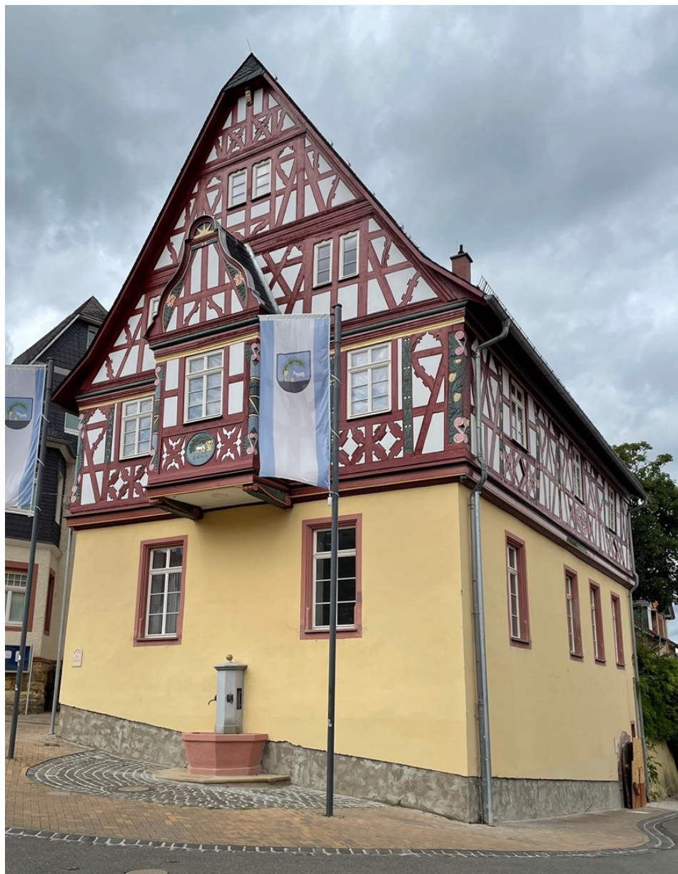
Das restaurierte „Historische Rathaus“ von Bodenheim nach der dreijährigen Sanierung. Bild: privat
